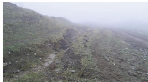
Şəkil 2. Daş karxanasına gedən yol. 2000 m-dən çox yağış, məhz ağır maşınların yükü hesabına əmələ gəlib
